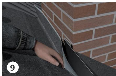
**9** Breite des Kehlstreifens richtet sich nach der Breite der seitlichen Anschlüsse auf der Dachdeckung ❶ seitliches Alu-/Rolloflex im Kehlbereich 90° hochbiegen ❷ Kehlstreifen hinter den Kamin legen und mit den hochstehenden Teilen des seitlichen Anschlusses „Kleber in Kleber“ zusammenfügen
